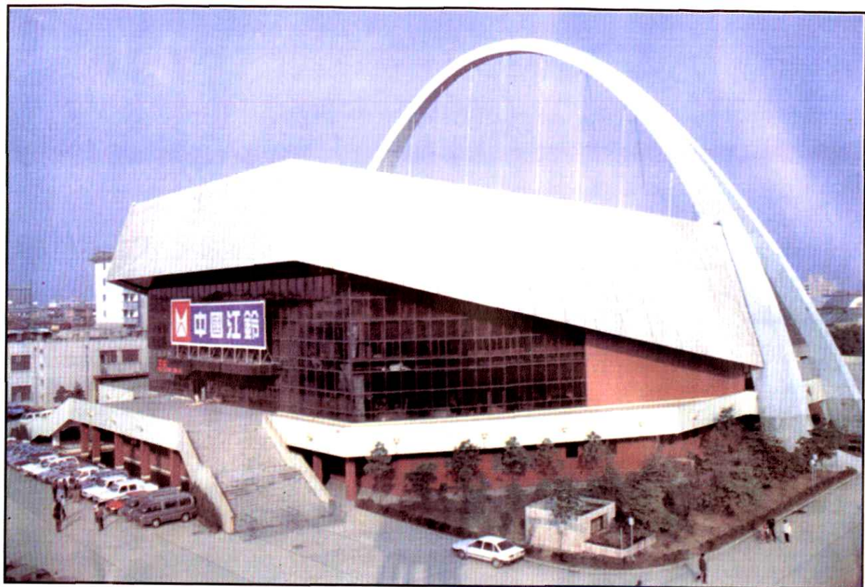
江西省体育馆是我省具有现代化水平的新型的省体育馆,大拱采用假载法施工工艺,获建设部科技进步新技术优秀项目奖
