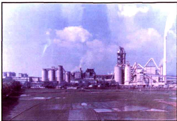
江西省水泥厂扩建工程日产 2000 吨熟料的大型干法生产线，获国家优良工程称号
