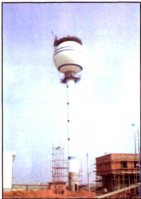
桑海荣欣招商开发区的球形水塔，容积300立方米，高45米，由司属土建企业开发建设，填补了我省球形水塔的空白
