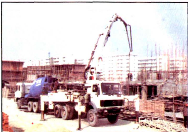
司属省建一公司砼搅拌站，从西德、法国引进大型砼泵车和砼搅拌站设备，年生产能力可达11万立方米高质量砼
