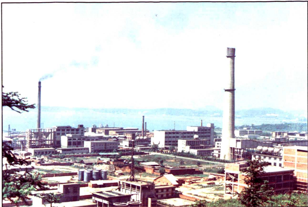
九江化纤厂一期年产粘胶长丝三千吨和二期年产粘胶短丝二万吨工程均由司属建安企业承建,后期工程安装了我国首次整套引进的国外粘胶纤维生产线,是我国最大的粘胶短丝生产项目
