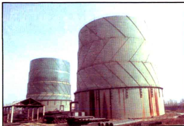
南昌煤气气源厂24万立方米气柜,被省建设厅授予优良工程
