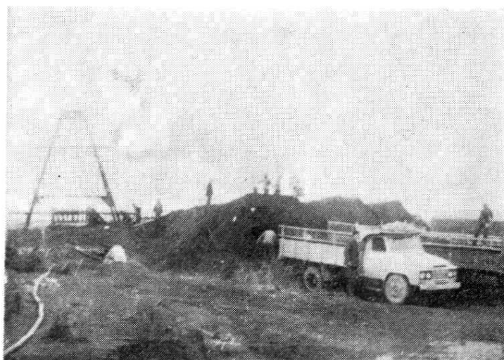
同 田 煤 矿 工 地
