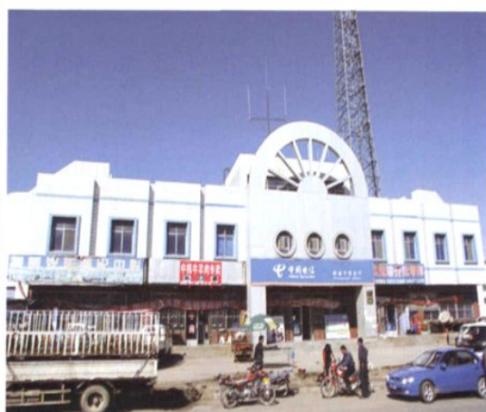
新城子电信大楼
