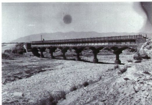
南干渠渡槽（唐家坡梁家庄）
