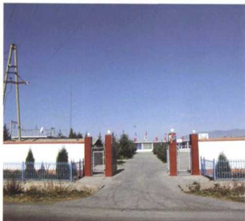
新城子供电所
