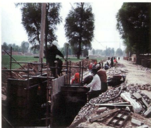
渠道建设施工现场
