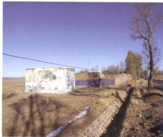
南湾村人饮工程高位水池
