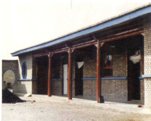
新中国成立后新城子首家 农村砖木结构走廊住宅
