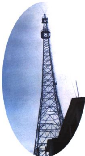
移动电话铁塔
