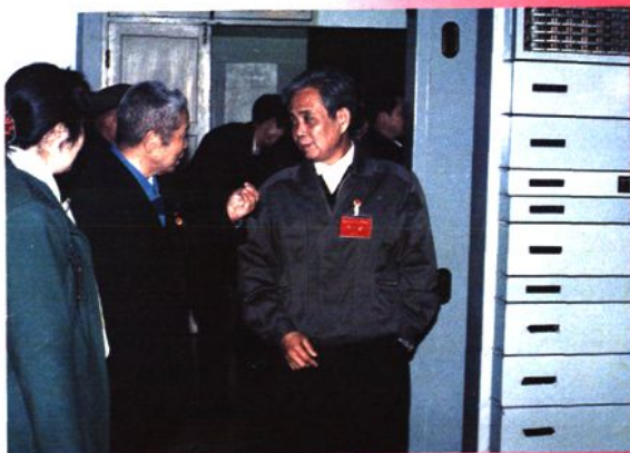
会议期间，区邮电管理局局长许振环（右一）视察鹿寨局自动电话机房
