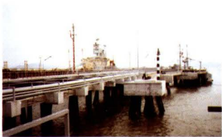
厦门博坦 10 万吨油码头
