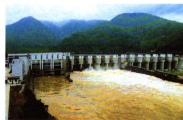
沙县城关水电站
