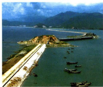
罗源松山围垦工程
