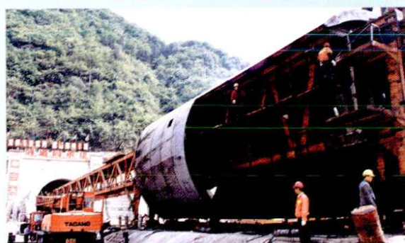
▲秦岭隧道施工中，我国首次使用的全断面掘进机
