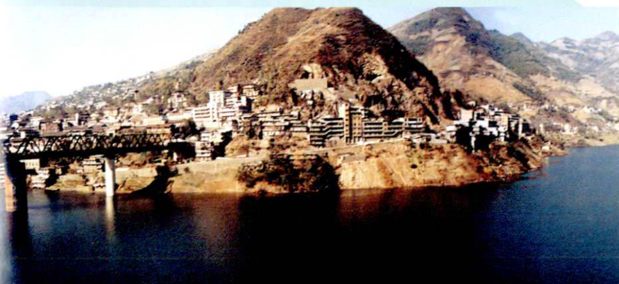
◀ 襄渝线紫阳汉江大桥，1970年10月开工，全长473米8孔，1973年4月全桥建成
