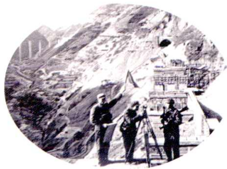
▲建设中的松树坡车站
