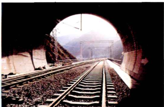
▼ 大瓢沟双线隧道与青岔四线桥相连
