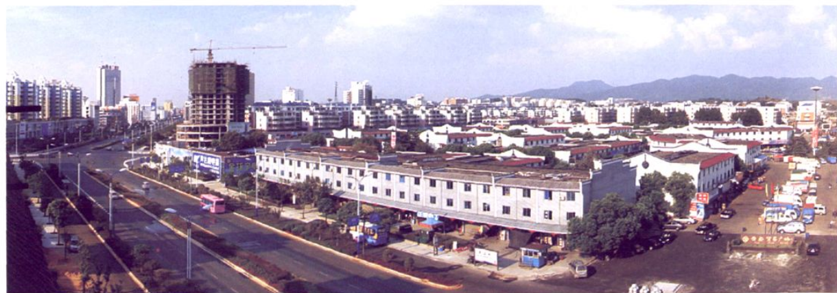
2010年9月，吉安贸易广场立面改造工程竣工。
