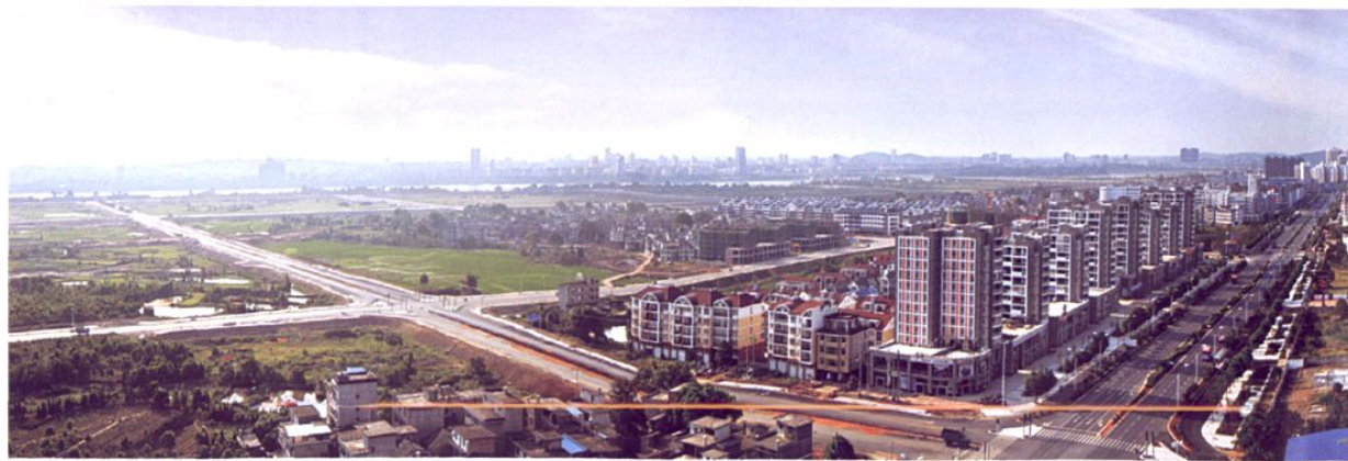
滨江路网和气路与白云路交汇处，青原大道及两侧城市建设状况。
