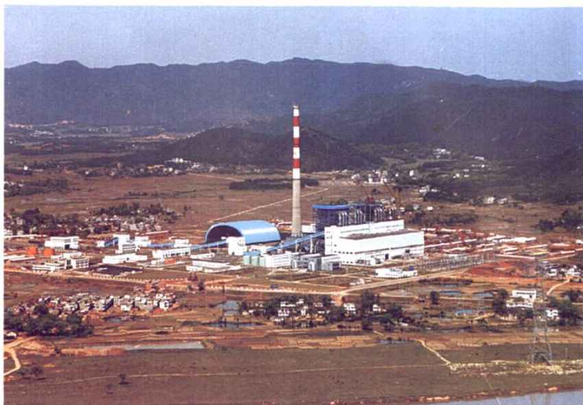
2000年5月25日，华能井冈山电厂一期工程完工。 2004年4月 航拍
