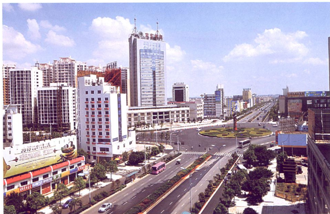
2010年6月，青原大道“白改黑”工程开工，2010年10月竣工。
