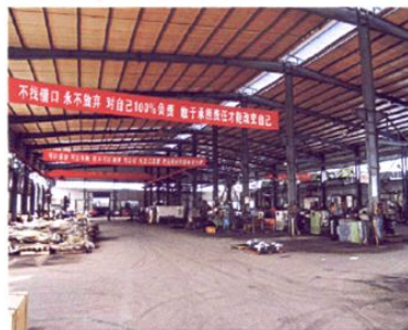
吉安锐迈管道有限公司厂房
