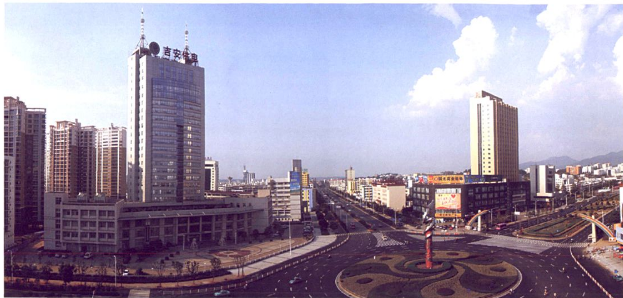
青原大道与文天祥大道交汇口周边城市建设状况。
