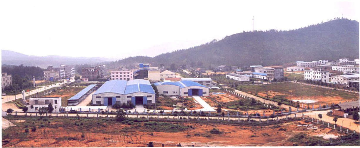
富滩循环经济工业区
