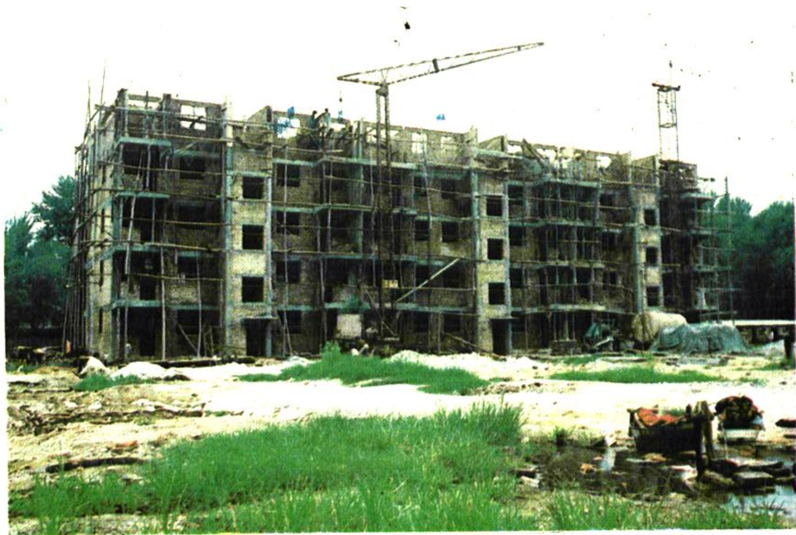
正在施工中的教工宿舍楼
