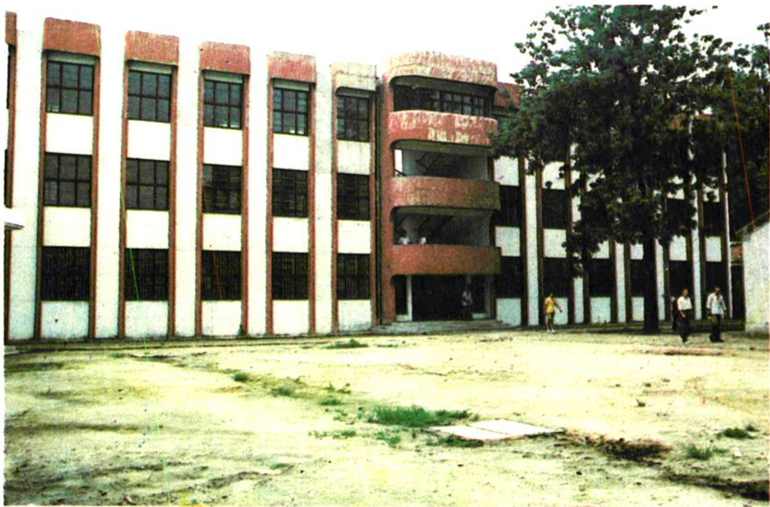
十二个教学班教学楼 建于1988年9月
