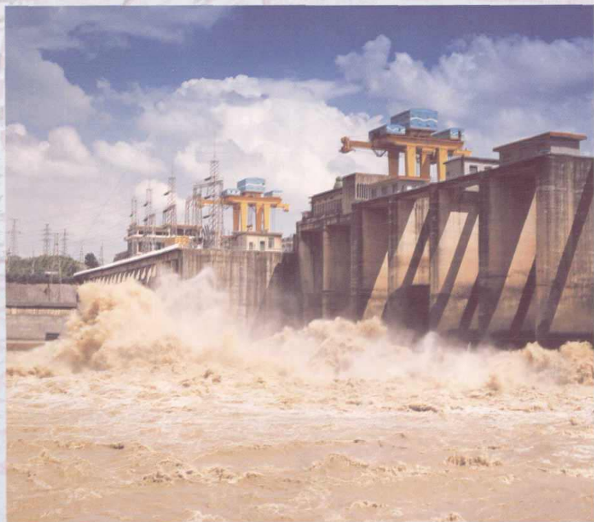
▲ 大化水电站下游泄洪景观
