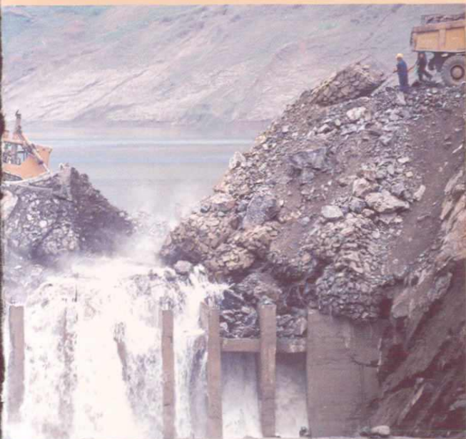
▲ 百龙滩水电站截流施工
