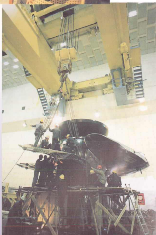
大化水电厂机组增容改造 ▶
