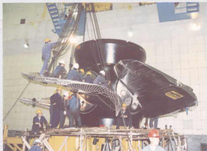
▲ 大化水电厂新转轮安装
