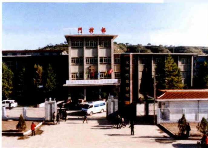
定西地区医院门诊楼
