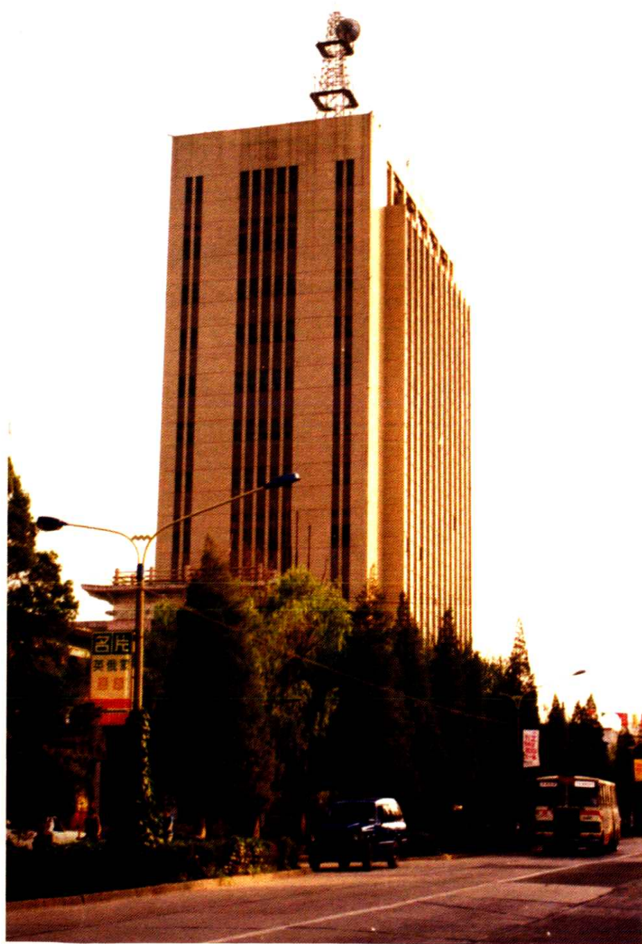
1986 年动工， 1988 年投入使用的 呼和浩特电信枢纽 大楼。
