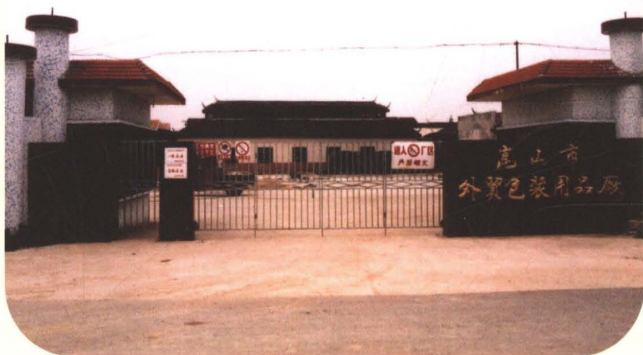
晟泰集团公司 1989 年建造的厂房
