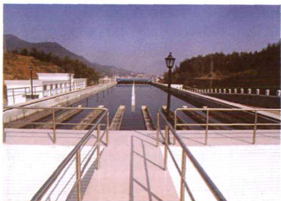
日产4万吨水的水厂蓄水池
