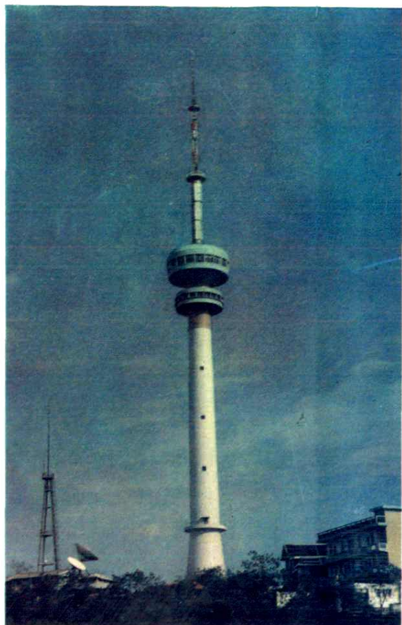
▲ 自贡电视发射塔
