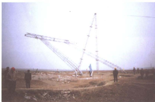
★ 1997年10月，山东诚信中标500千伏邹—临输变电工程138千米、 1 \times 750 兆伏安施工监理、施工招标代理，系公司监理的第一个500千伏输变电工程。
