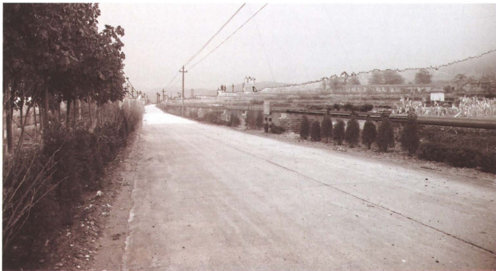
★1996年10月，山东诚信签订石横 2 \times 30 万千瓦电厂9.7千米运渣道路施工监理合同。
