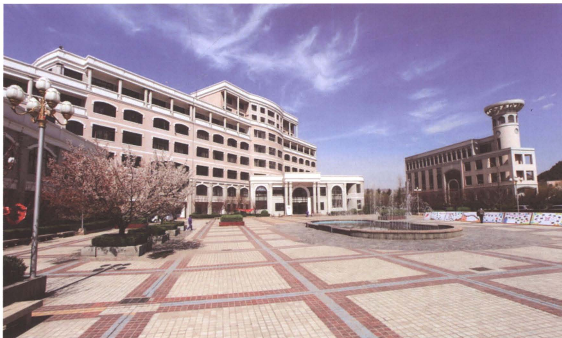
★ 1997年2月，山东诚信中标山东电力干部培训中心、电力研究院图书馆等工程监理，系公司监理的第一个房屋建筑工程。
