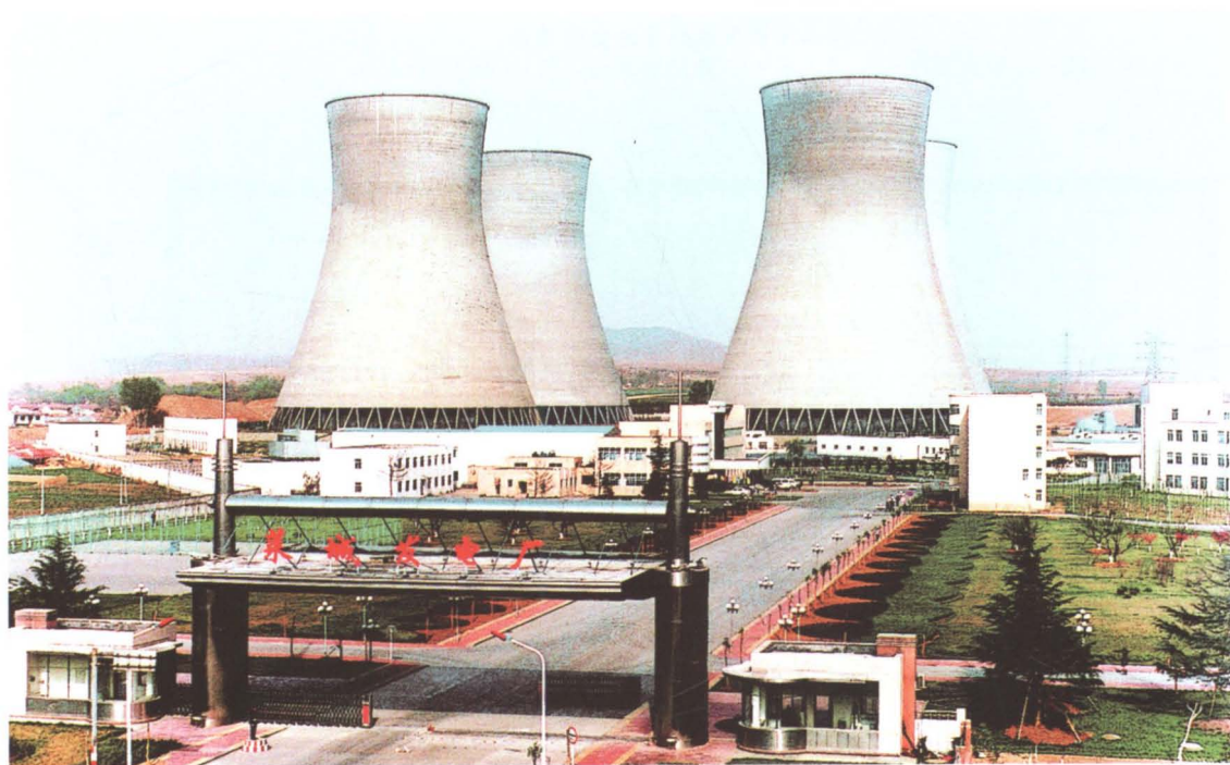
★ 2001年3月，山东诚信中标莱城电厂一期续建#3、#4机组 2 \times 30 万千瓦工程施工监理。该工程获得2004年度中国建设工程鲁班奖。
