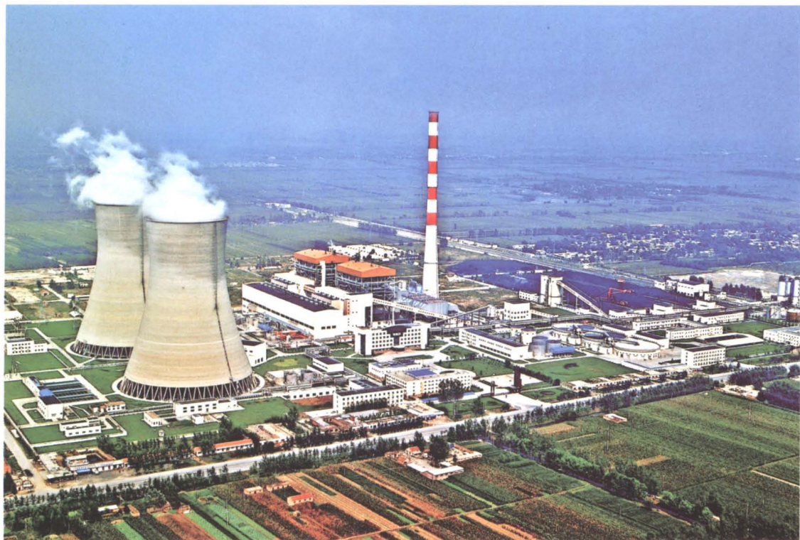
★ 1998年1月，山东诚信中标山东中华电力聊城电厂一期 2\times 60 万千瓦工程施工监理、施工招标代理，系公司监理的第一个 2\times 60 万千瓦级机组工程。该工程获2005年度中国建设工程鲁班奖。
