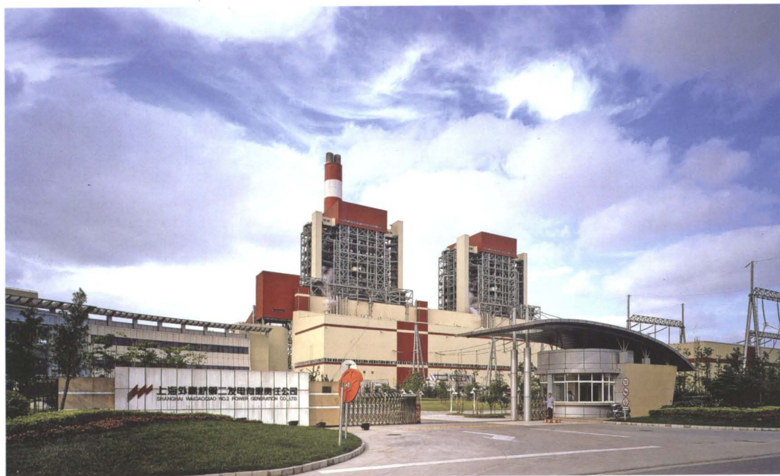
★ 1999年10月，山东诚信中标上海外高桥电厂二期（ 2 \times 90 万千瓦）工程#5机组安装及全厂BOP安装施工监理，系公司监理的国内首台百万千瓦等级机组工程。
