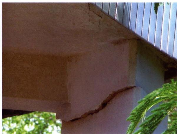
2004年9月17日,广东省阳江市平冈镇发生4.9级地震,阳江市上洋联甫盐小学一墙体裂缝
