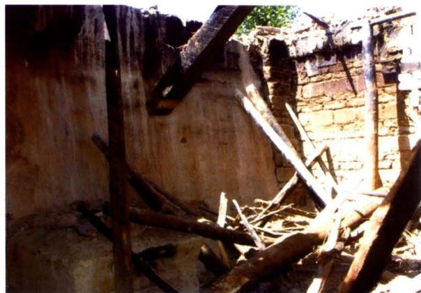
2004年9月7日,甘肃省岷县—卓尼发生5.0级地震,震区土木结构房屋屋顶塌落
