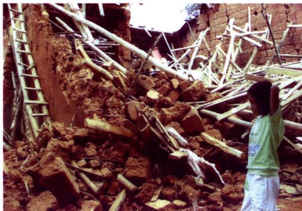
2004年8月10日,云南省昭通市鲁甸县发生5.6级地震,图为鲁甸县桃源乡白泥沟村砖木结构房倒塌(Ⅷ度区)
