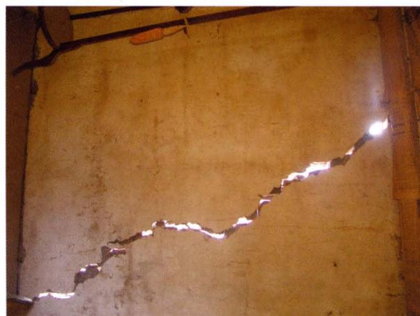
2004年11月21日,重庆市石柱土家族自治县发生4.6级地震,龙沙乡油坊村玉台组向大胜家土墙裂缝
