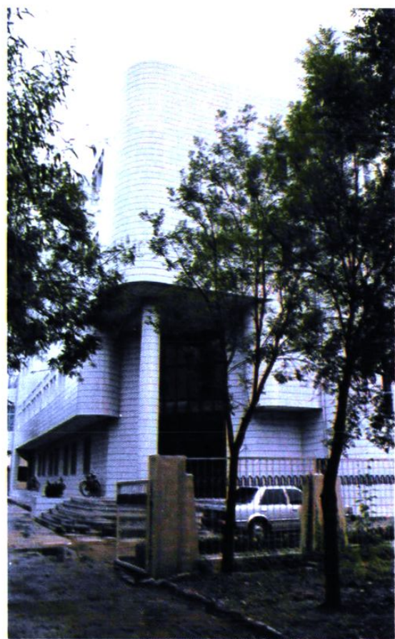
1994年5月18日交付使用的现代化新制剂楼。
