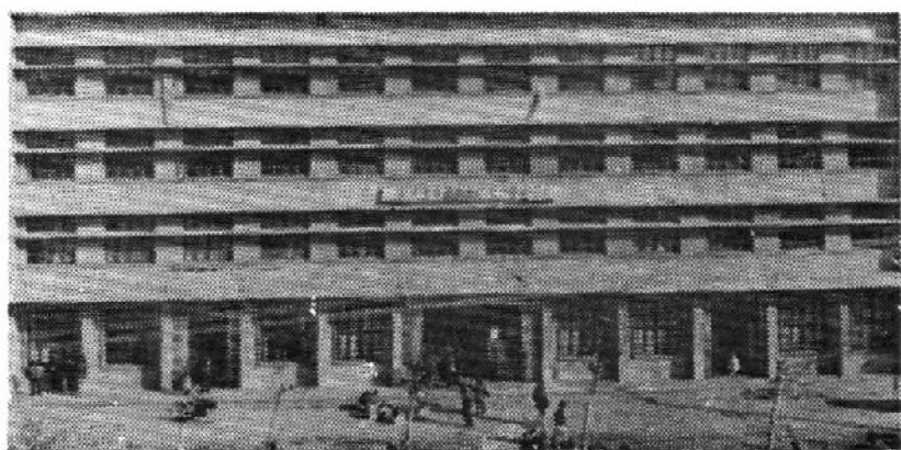
县社办公大楼正面图
