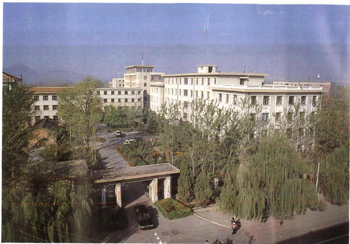
房山区委办公楼
