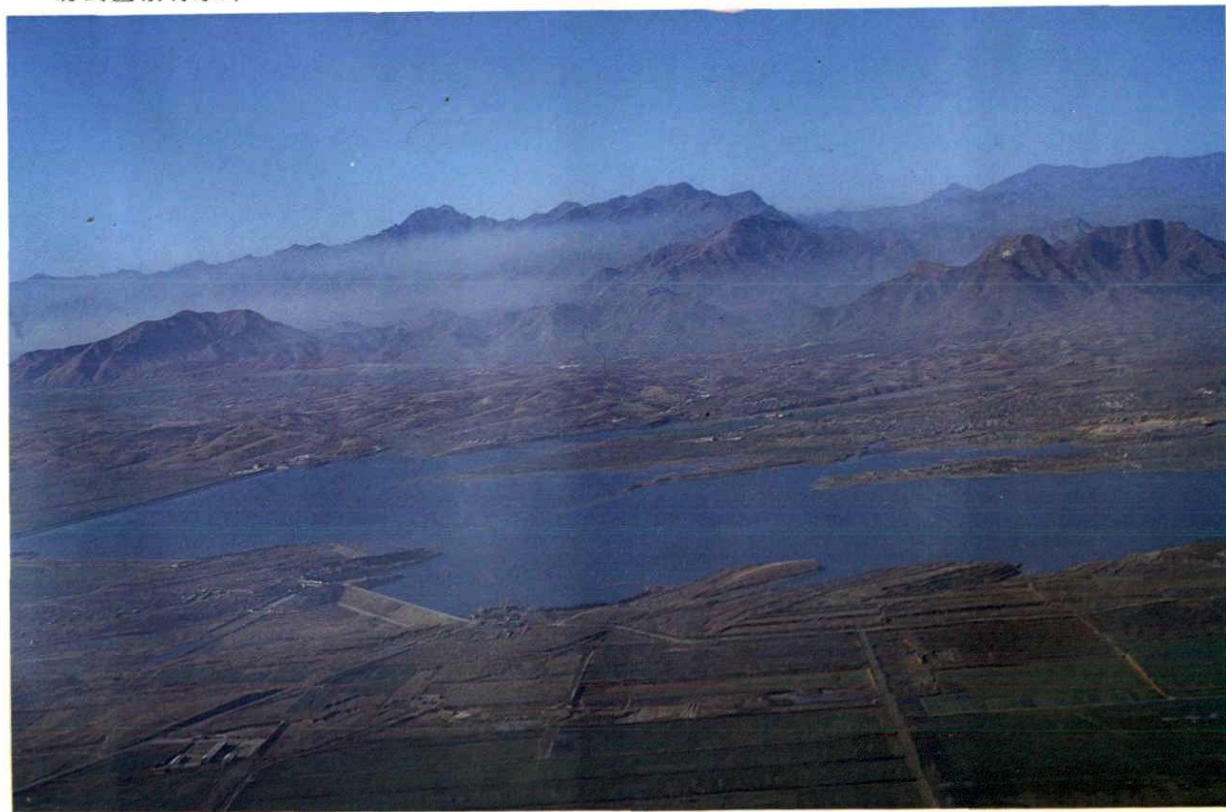
房山区崇青水库
