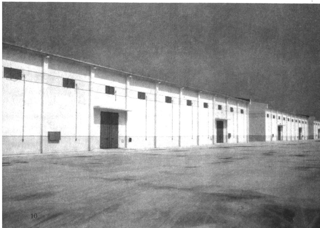
营城粮库房式储粮仓(200 亿斤项目)
