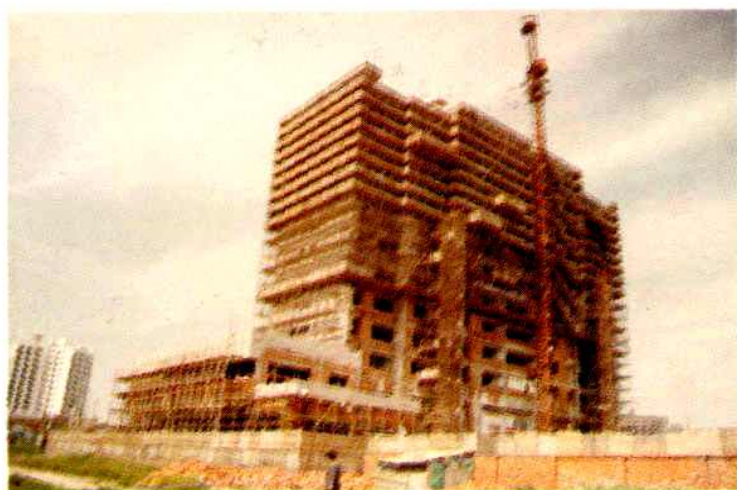
常熟市建公司驻苏 沙家浜工程处建筑工地
