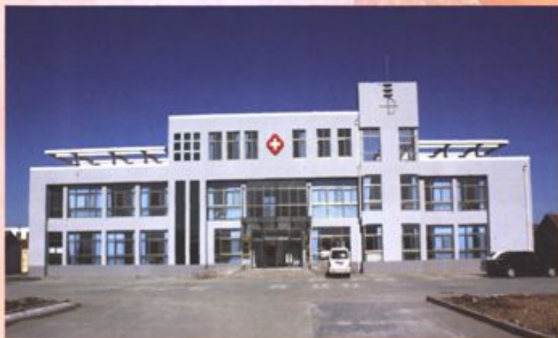
太平乡卫生院综合服务楼
