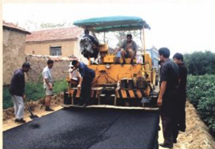
乡村公路建设
