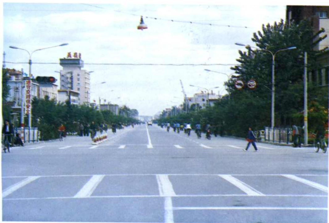
扩建后的昌平县政府街道路一角
