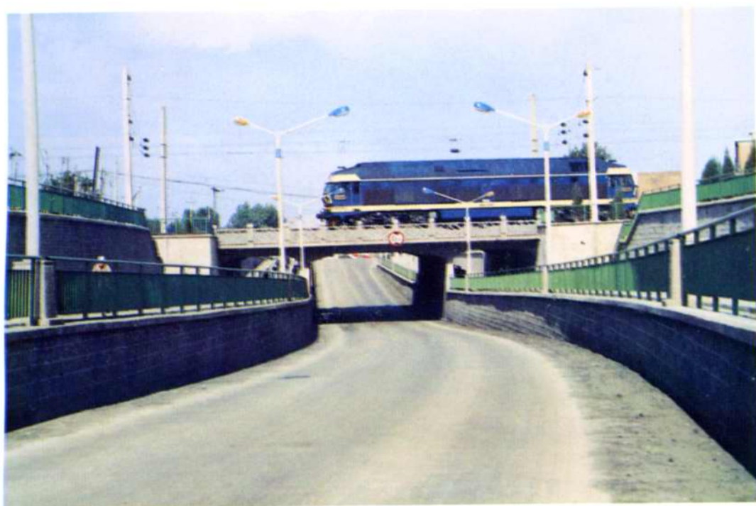
沙阳公路立交桥
