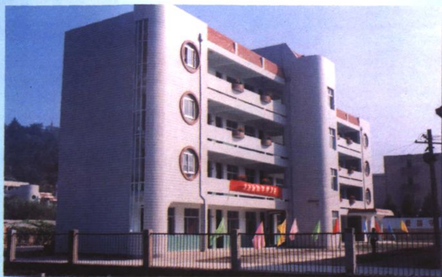
东山镇第三小学综合楼
