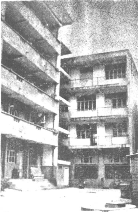
左图：青川县商业局办公 大楼一角
