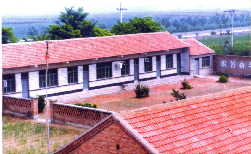
局为各供电所建起了五间房独门独院的办公场所。图为凤翔供电所。
