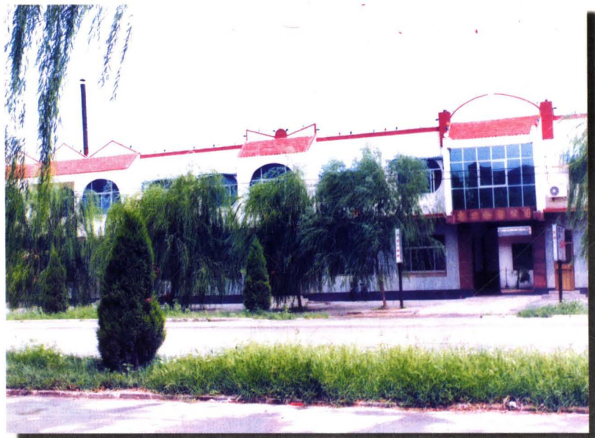
县电力局物资供应公司外景
