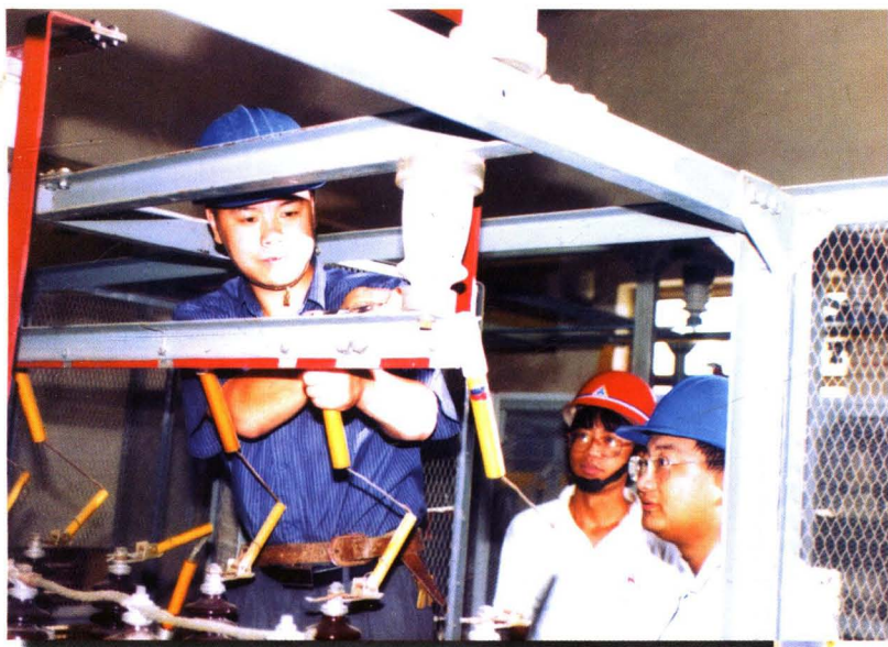
局供电科维修班在检修变电站设备。
