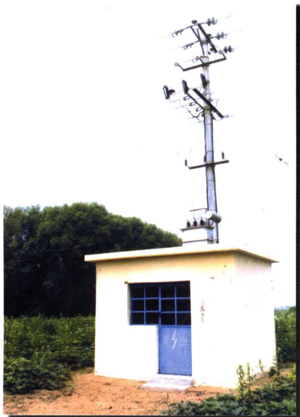
农网改造后,建成的标准的农村配电变压器台
