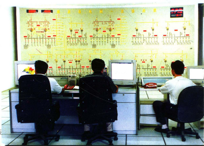
为推进现代化办公，局为各科室、各 电所普遍安装了微机。图为生技科微 机室。
