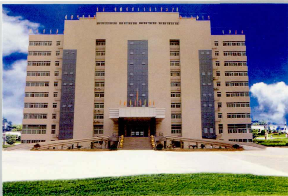
揭阳经济开发试验区管委会办公大楼
