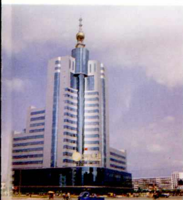
★ 揭阳电信大楼
