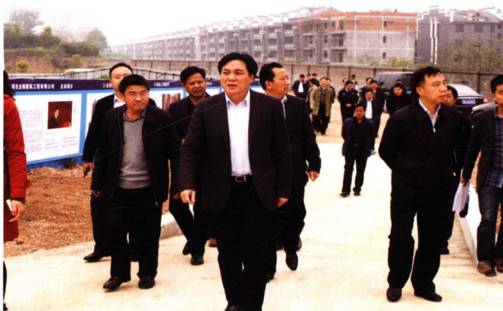
2016年3月29日，市委书记罗联峰（中）在新建档案馆工地检查指导建设工作。
