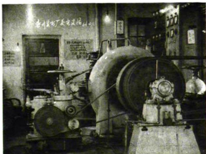
←喜州万花溪 小型立式水轮 发电机为资源 委员会中央机 器厂1944年制造。
