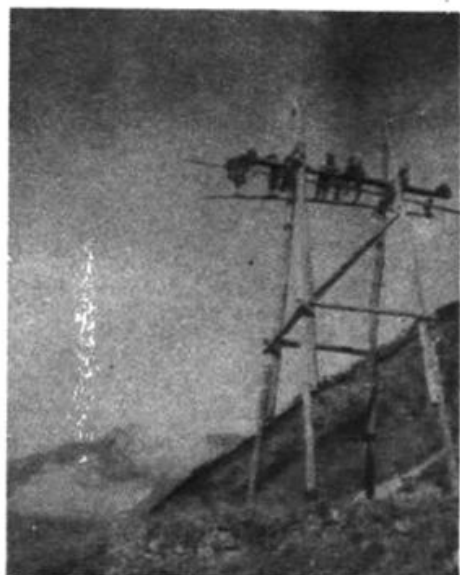
↓ 滇西第一条35千伏输电线 路于1959年建成。
