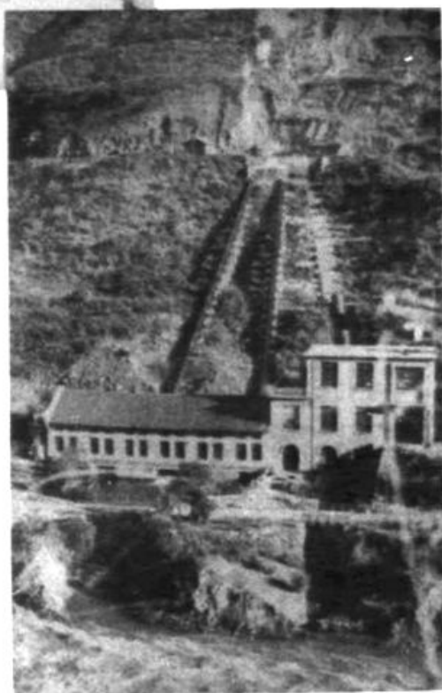
→西洱河朝地田电 站。
