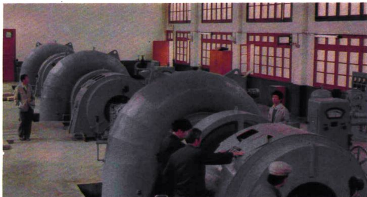
↓米子坪电站 2 \times 3000 千瓦水轮发电机组。
