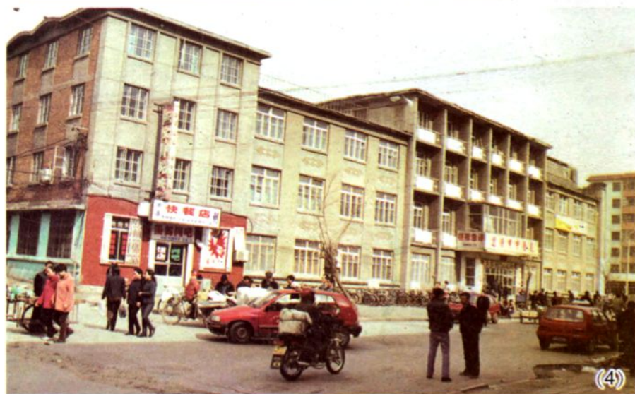
图 4、一九九〇年医院将与院综合楼西南角紧紧相连的市房产局建的四层楼买下二至四层，将居民动迁出去，建筑面积总共为 576.72 平方米，作院党政工团等机关工作人员办公室。
