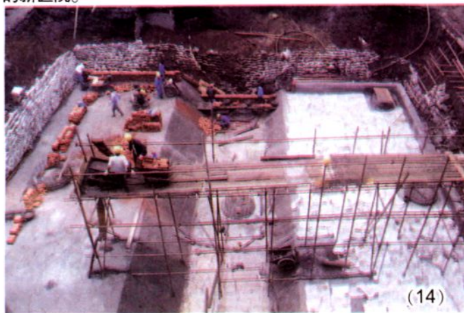
图 14、2002 年 6 月 27 日由市龙宇建筑总公司第六分公司承建的综合大楼工程开工。这是施工中的裙房楼的地下工程。
