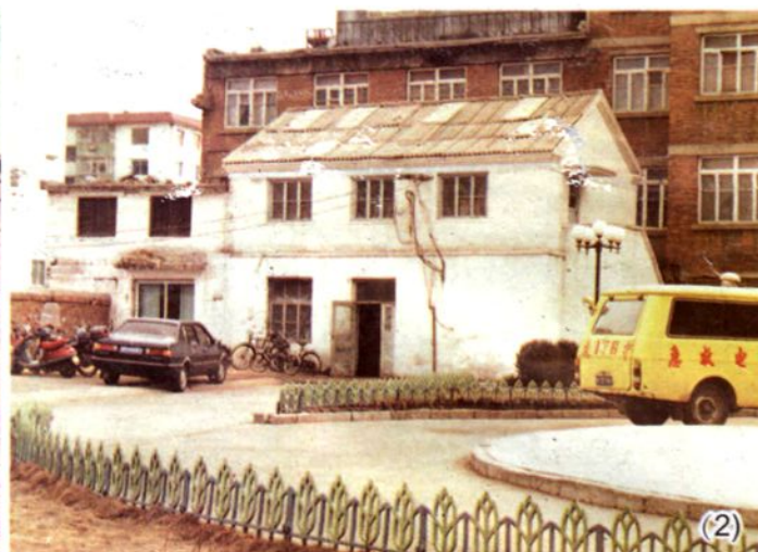
图 2、1984 年夏，医院为适应把以西医为主的综合医院改造成以中医为主的综合医院的需要，把在综合楼后院建筑面积为 70 平方米的平房制剂室再往高往长接出建筑总面积为 248 平方米两层小楼，作中药库、西药库和中药成药库等。
