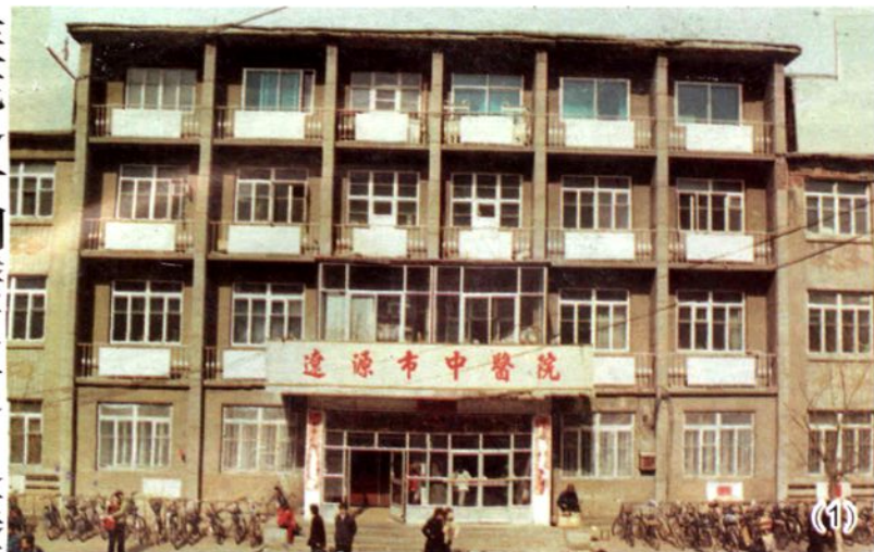
图 1、1977 年 9 月市经委建的医院前身辽源市工业职工医院，呈“343”凸字形、占地 1800 平方米、建筑面积 2140 平方米的综合楼。1984 年 3 月，市卫生局将其接收过来交给新组建的辽源市中医院领导班子和全体职工。
