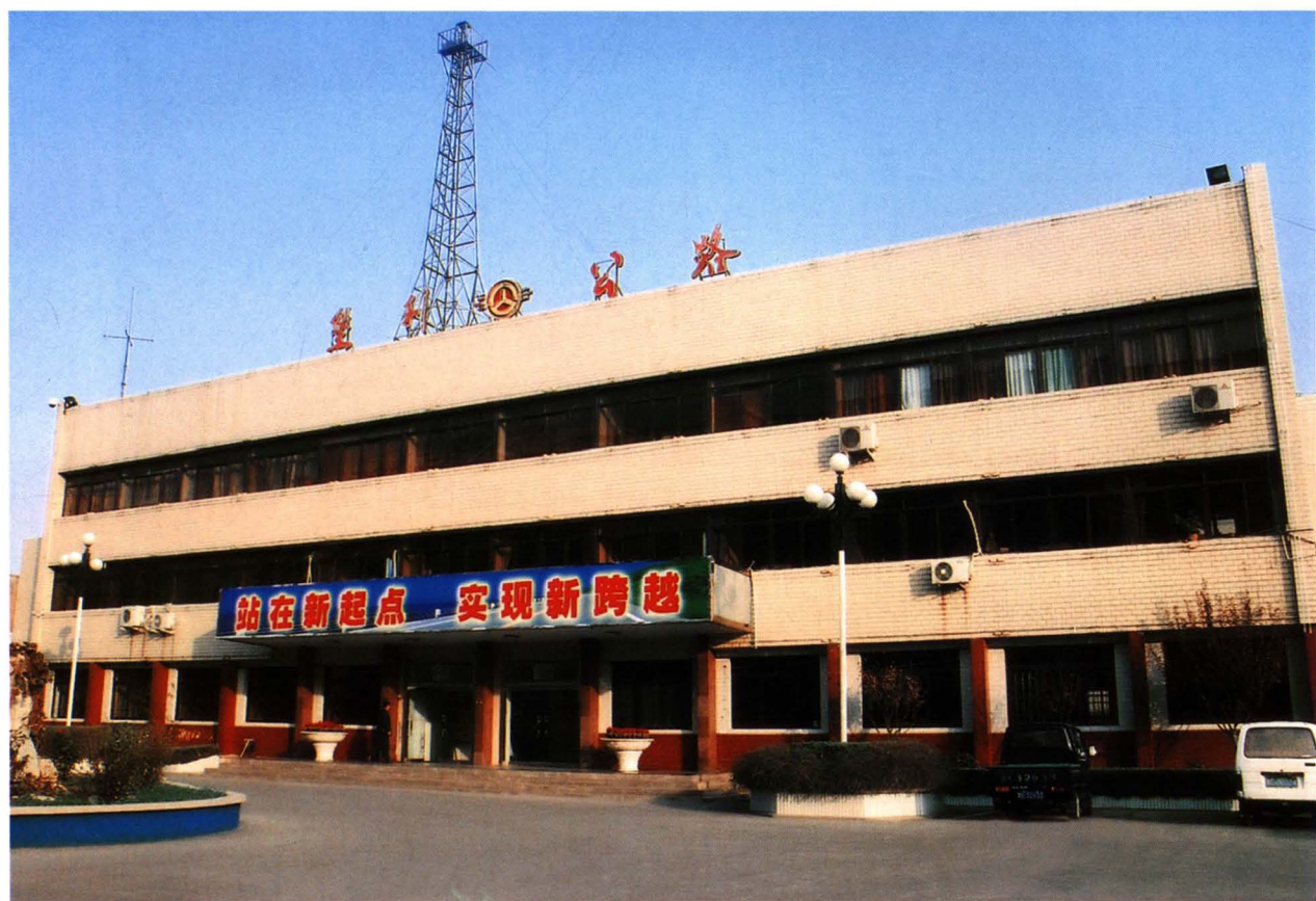
垦利公路局办公楼
