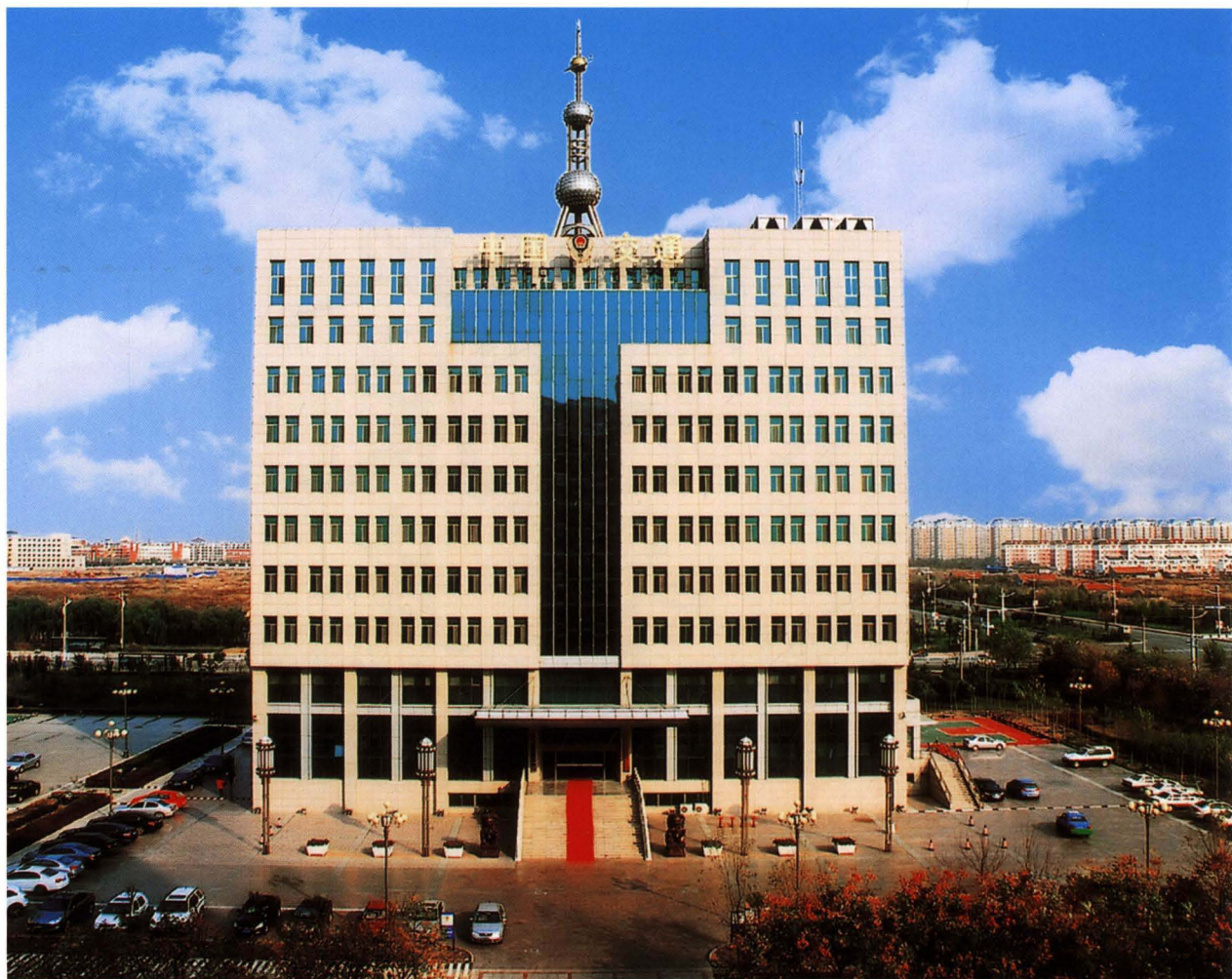
垦利县交通局办公楼
