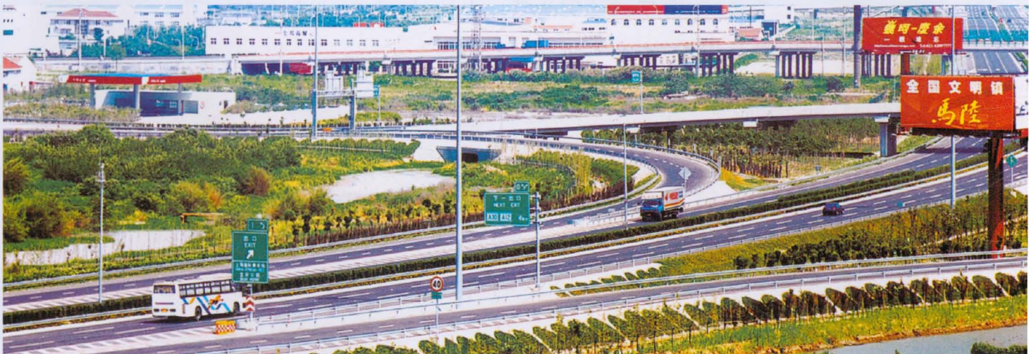
途经马陆镇的A30（郊区环线）2003年竣工通车
