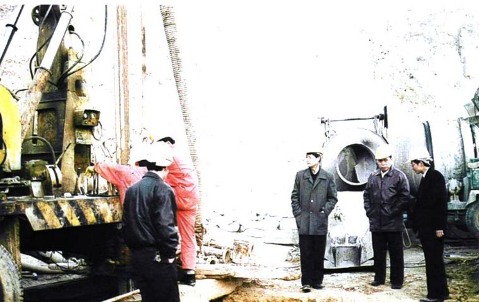
段子清副厅长 视察我队基础 工程公司工地
