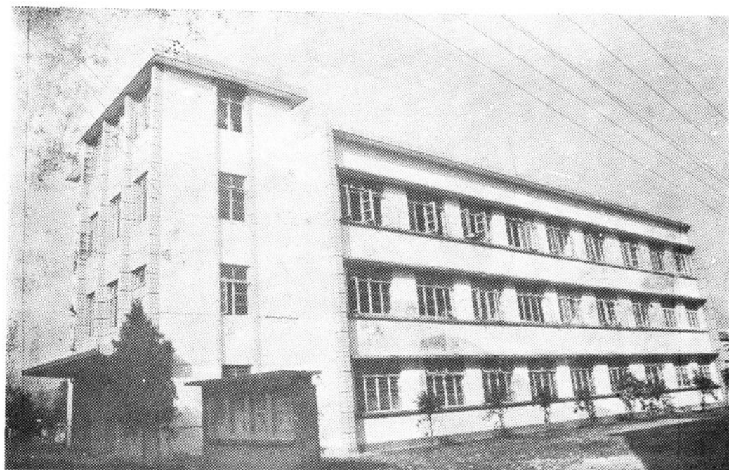
崇仁区卫生院住院楼
