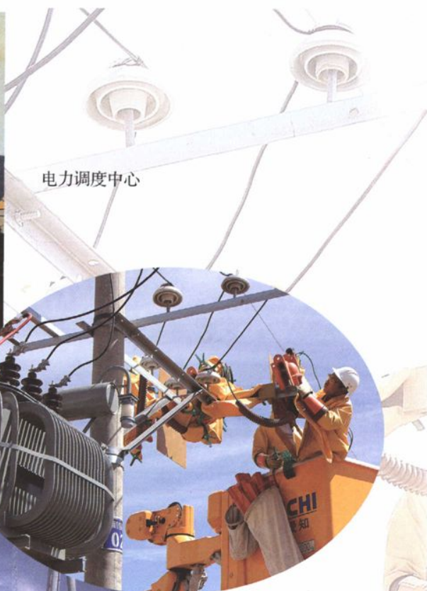
先进的带电作业设备
