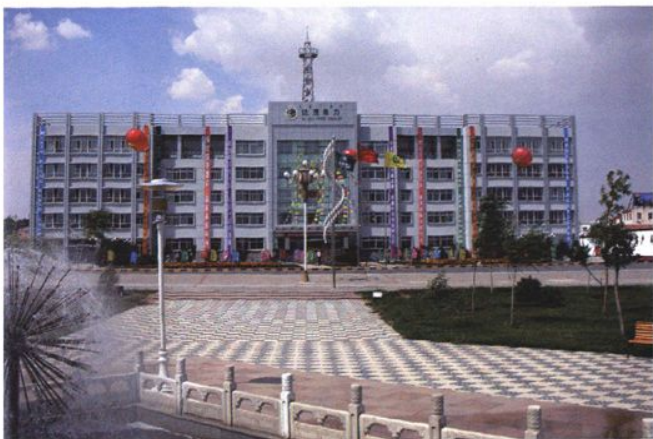
电力公司调度大楼
