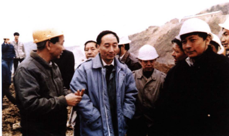
1991年3月， 能源部副部长陆 佑楣（左二）在五 强溪建设工地检 查工作
