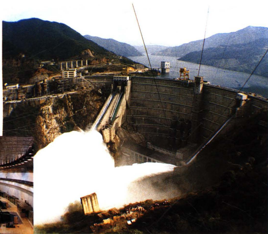
70 年代国内第一座大型空腹重力拱坝——凤滩水电厂全景及其坝内式厂房
