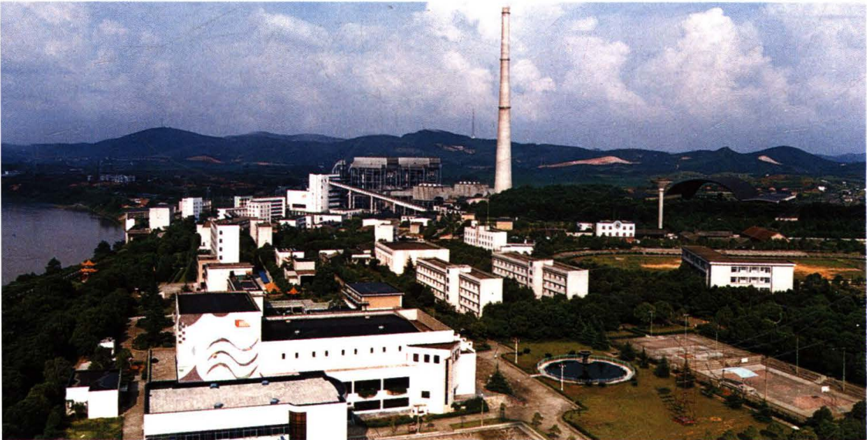
华中电网首家获得全国“一流火力发电厂”称号的耒阳电厂
