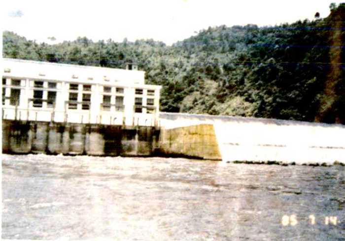
龙南县牛迹潭水电站
