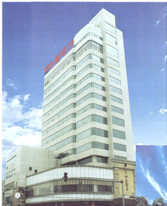
1. 2000 年 10 月，溧水县电力实业总公司办公大楼（后改造为“溧水中心大酒店”）
