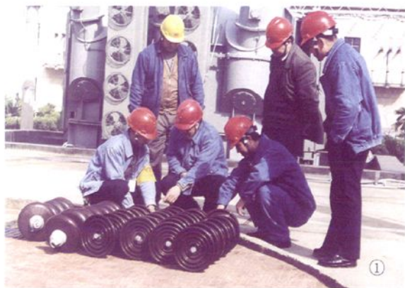
1. 2000 年 4 月，溧水县供电局安全监察员与检修人员在 110 千伏秋湖变电站检修现场检查绝缘子串
