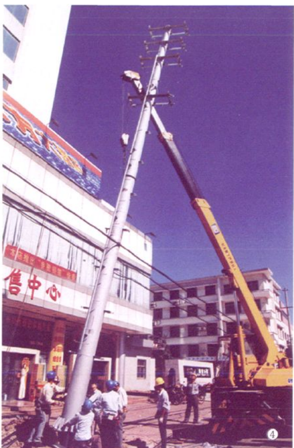
4. 2002 年初，溧水县供电局职工在珍珠北路 10 千伏线路改造现场施工
