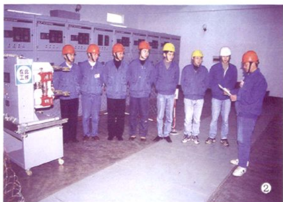
2. 2000 年 11 月，变电检修班工作人员在 35 千伏城中变电站检修前例行开工会
