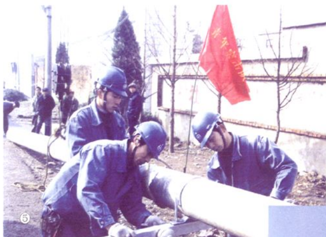
5. 1999 年 4 月，永阳镇农村电网建设与改造新架线路现场
