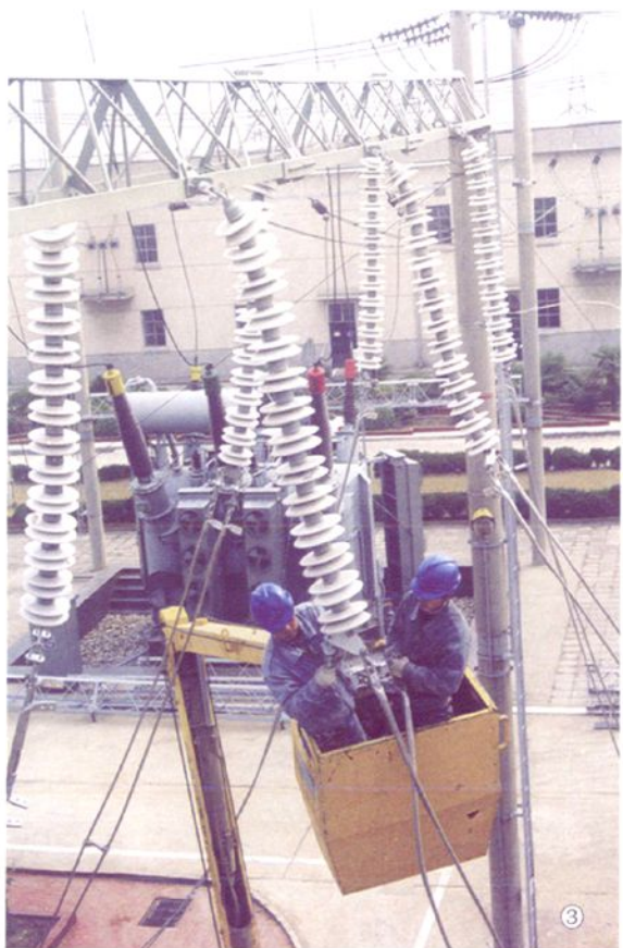
3. 2001 年 5 月，220 千伏东（善桥）—溧（水）线竣工投运，工作人员在投运前检查引线搭线质量
