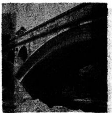
龙潭岩湾石肋拱桥
