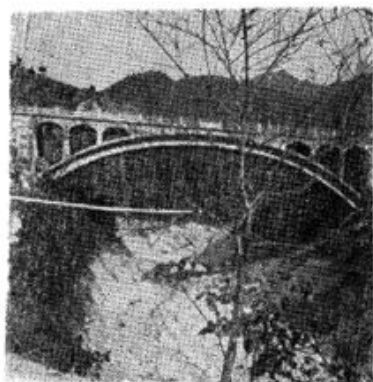
(图23) 边桥坑大桥
