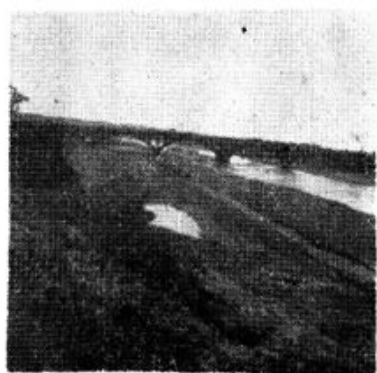
(图13) 麻阳水大桥
