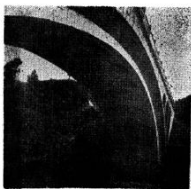
边肋拱桥拱圈结构
