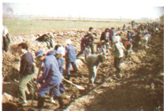
大家动手、疏浚沟渠。
