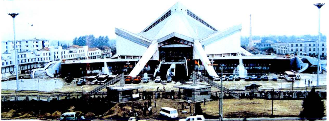
建设中的汉中体育馆
