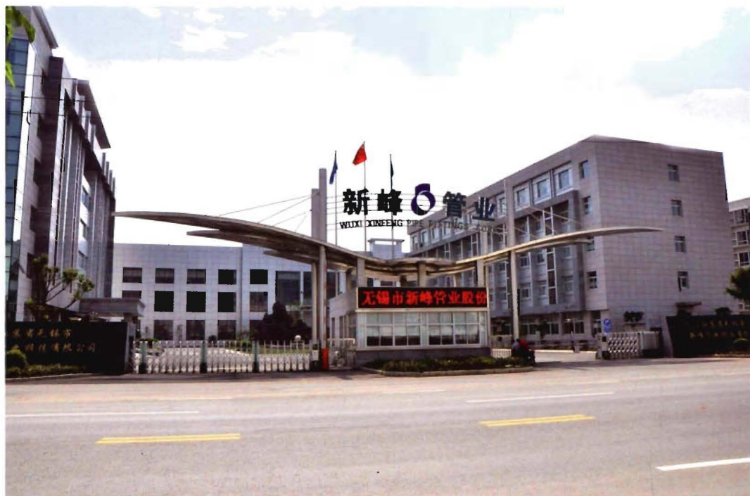
无锡市新峰管业有限公司新厂区
