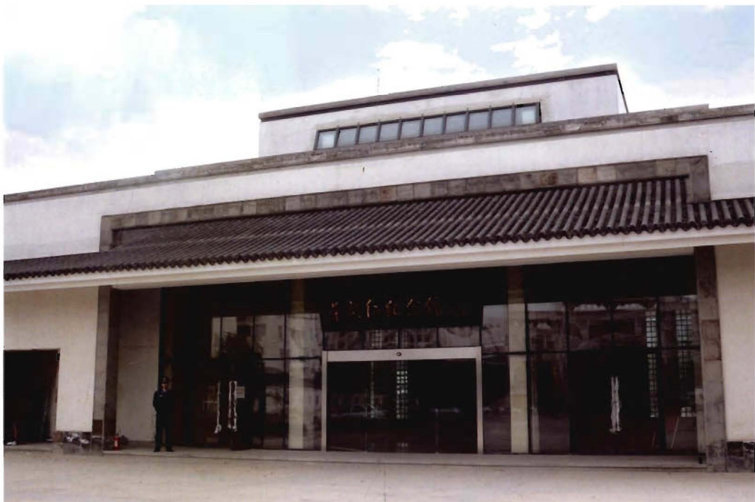
2009年，正在建造的荣毅仁纪念馆
