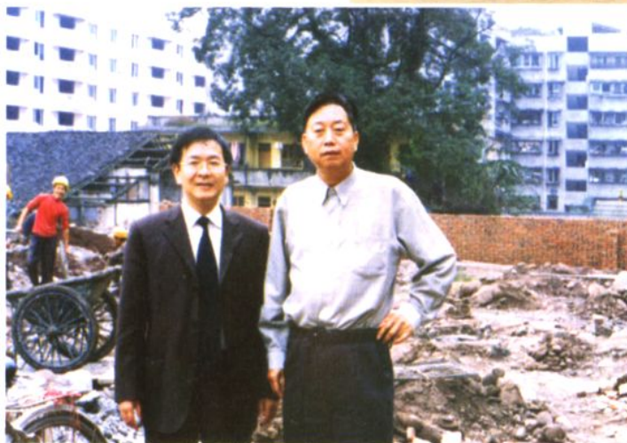
◀ 省工商局副局长章立（右）视察沐川县工商局新办公楼施工现场。
