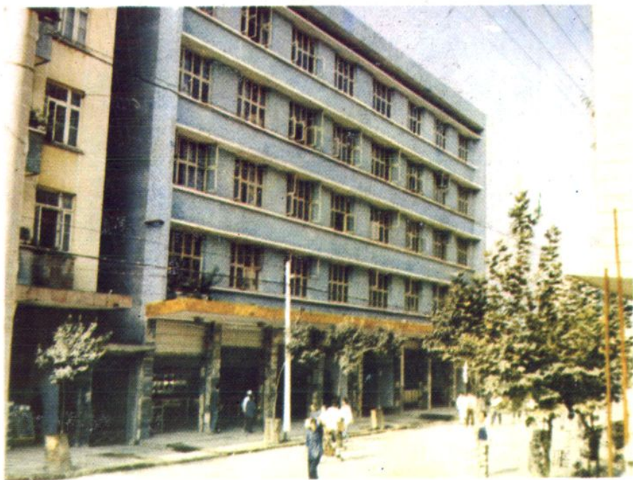
四川省蚕丝公司射洪县公司 办公大楼
