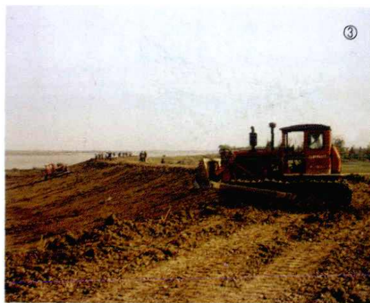
1.大路机电排涝站 2.龟头水闸 3.机械化修筑江堤 4.抛石治坍
