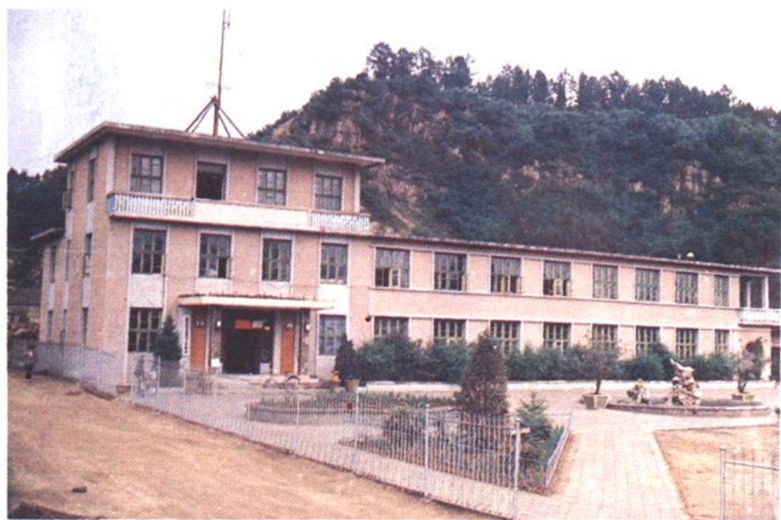
国营北三家林场办公楼
