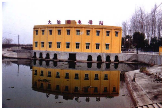
大治港电排站 洪锋摄
