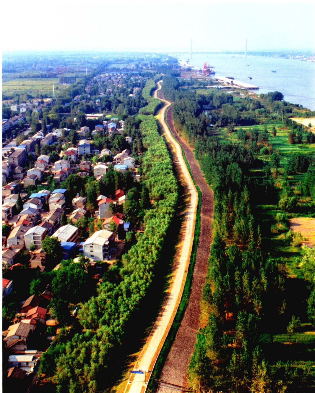
耙辅大堤 鄂州市河道堤防管理处提供
