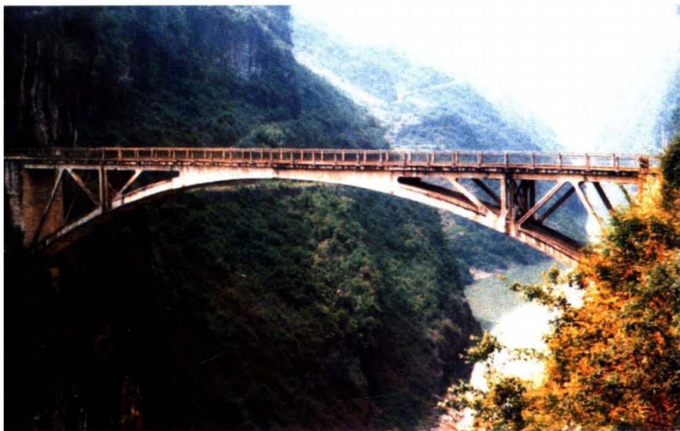
国内首座预应力钢筋混凝土桁架拱桥——道真自治县长岩大桥
