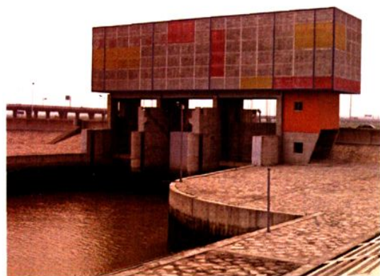
芦潮引河水闸
