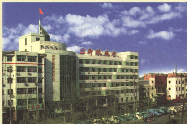
第三阶段：大庆东路27号，衡水橡胶股份有限公司， 1996~2013年，现称老厂区，待开发
